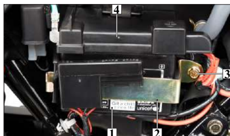
(1) Batería (2) Abrazadera de Batería (3) Perno (4) Tapa de caja de las terminales de la batería
